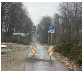
Exemplarischer Pfosten mit Überbreite im unteren Bereich (Quelle: Stadt Nettetal)
